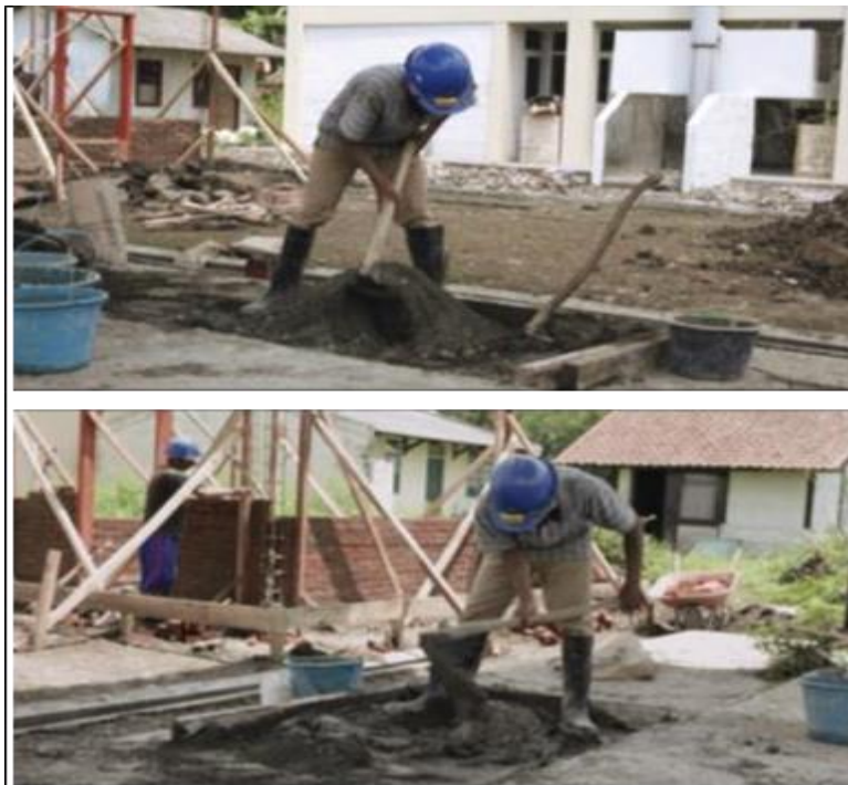
Gambar 8. Proses Pencampuran Mortar
