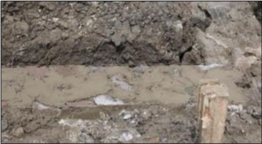
Gambar 11. Pondasi Dari Batu Kali/Gunung
