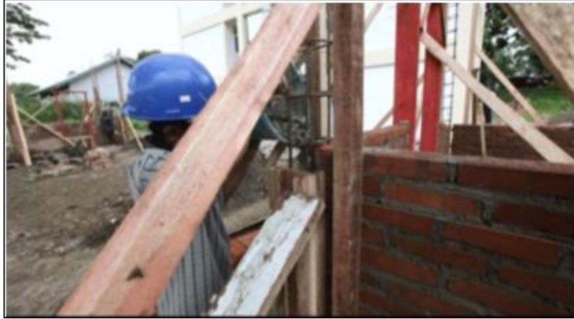
Gambar 56. Proses Pengecoran Kolom
