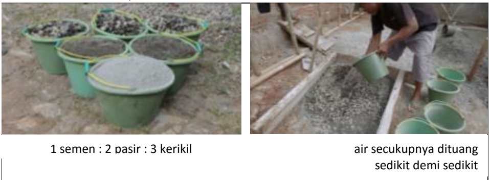
Gambar 2. Pencampuran Beton
