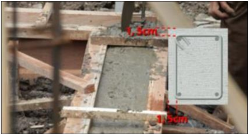
Gambar 19. Balok Pengikat/ Sloof
