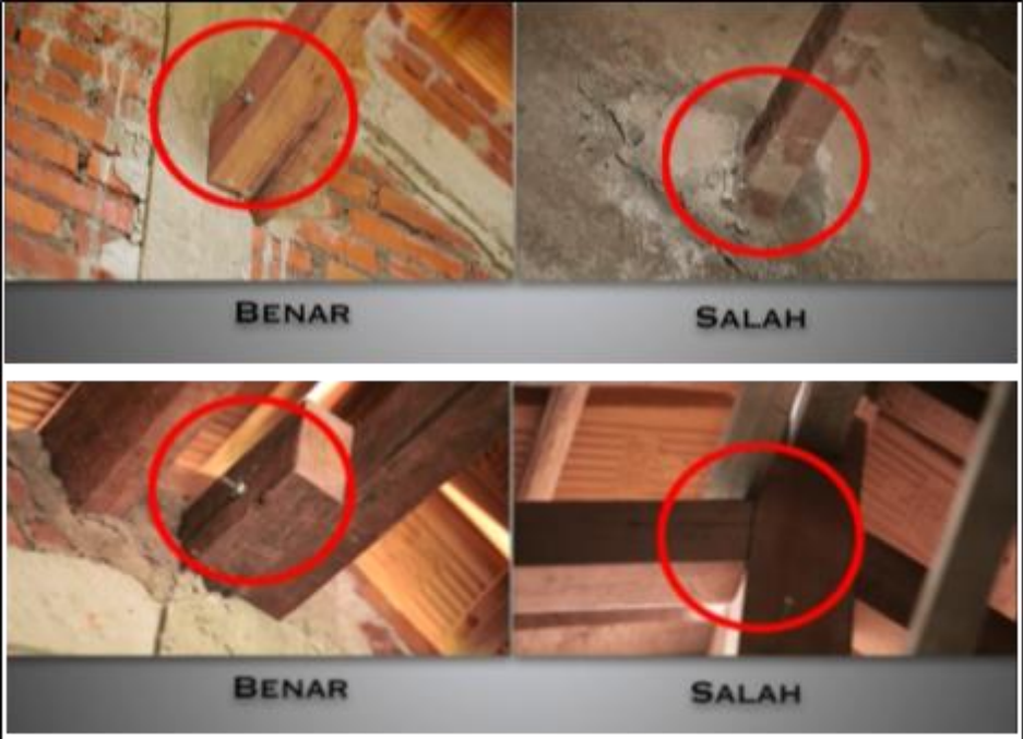
Gambar 38. Detail Pertemuan Antara Ikatan Angin dengan Gunung-Gunung/ Ampig
