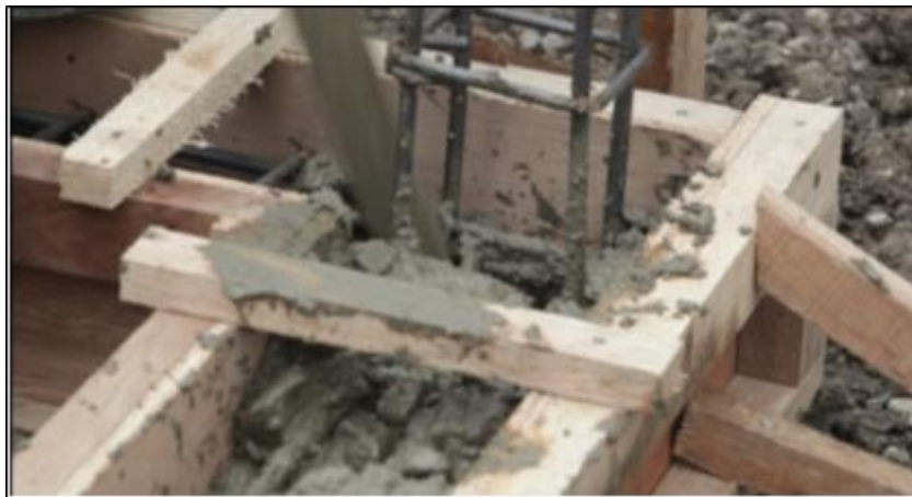
Gambar 58. Pengecoran Balok Pengikat/ Sloof
