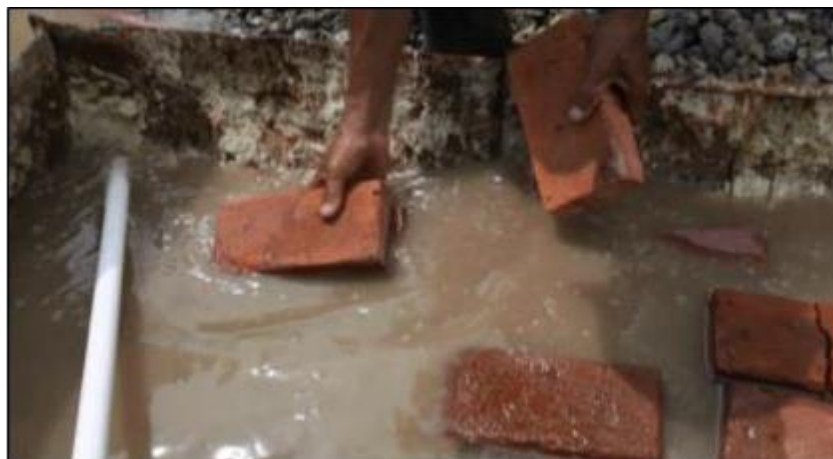
Gambar 15. Perendaman Batu Bata Sebelum Dipasang Batu bata yang baik pada saat direndam tidak mengeluarkan banyak gelembung dan tidak hancur.
