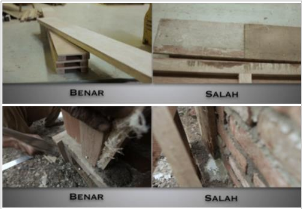
Gambar 54. Kualitas Cetakan/ Bekisting
