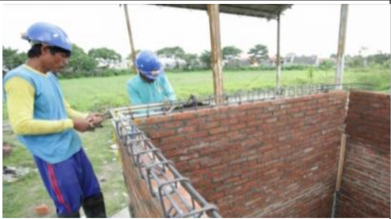
Tulangan balok keliling/ ring dirangkai di atas dinding
