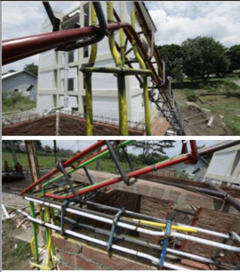
Gambar 53. Hubungan Antara Tulangan Bingkai Gunung-Gunung/ Ampig dengan Tulangan Kolom dan Balok Keliling/ Ring
