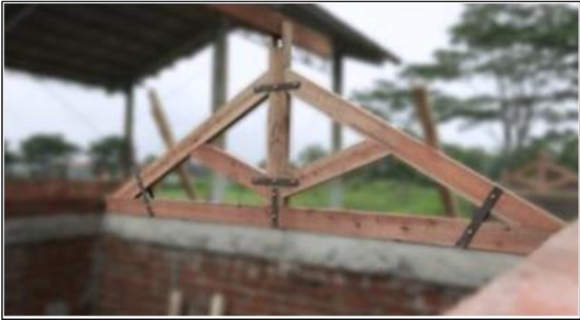
Gambar 28. Kuda-kuda Kayu Dengan Pengikat Plat Baja
