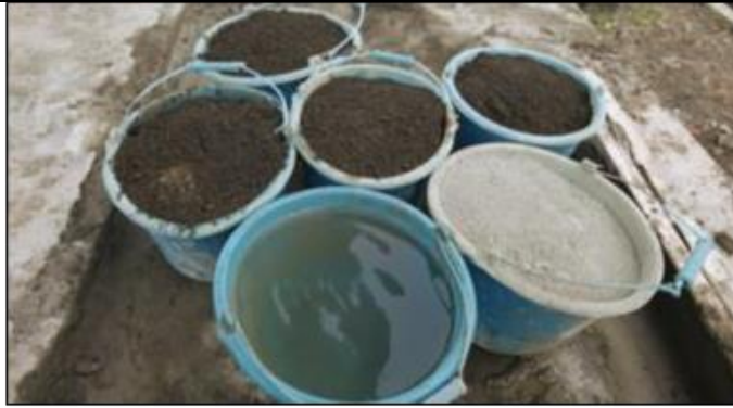
Gambar 7. Bahan Campuran Mortar
