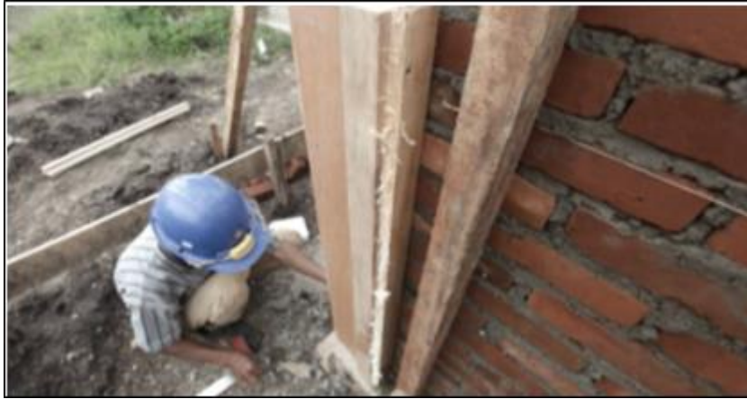
Gambar 55. Pemasangan Cetakan/ Bekisting Untuk Kolom
