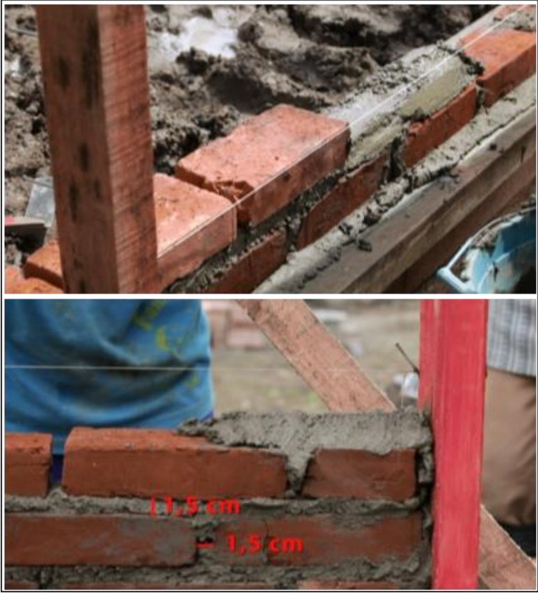
Gambar 41. Proses Pemasangan Batu Bata Untuk Dinding
